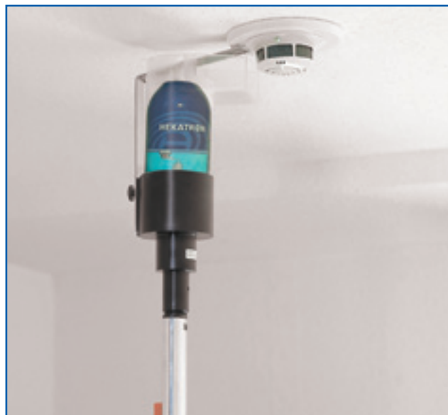
Wartung einer Feststellanlage
